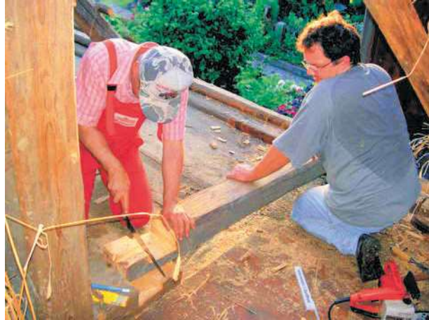
Max Spitzbarth und Alexander Strunz beim Auswechseln eines maroden Balkens
